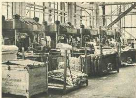
In der Vliesherstellung scheint es so, als befände man sich in einem Textilbetrieb. Hier werden die Vlieslagen zu Duroplastteilen gepreßt.
