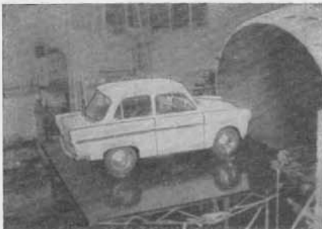
Bild 7 Der Trabant 601 im Windkanal
